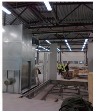
【嵩上げピット 埋め込み】
