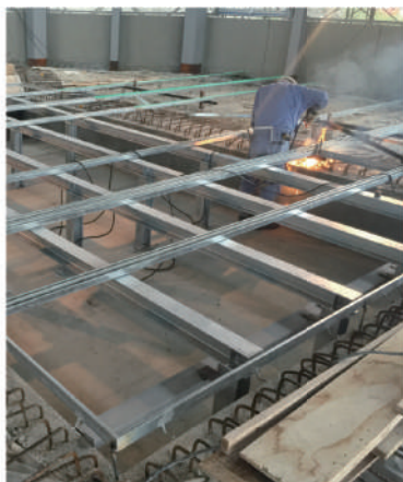
【コンクリートピット 建築架台】
