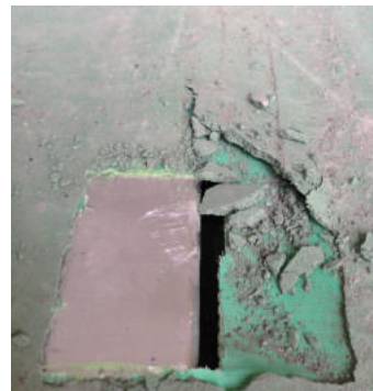
養生テープが埋まってしまうほどのレベルで打設されたコンクリート機器が正常に使用できなくなります。
