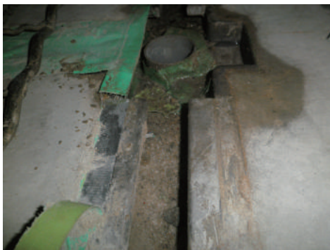
養生テープが剥がれてそのまま放置されたフロアレーンは変色しひどい状態になってしまいます。
